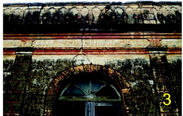
Fig. 01 a 03: aspectos gerais e detalhes construtivos
