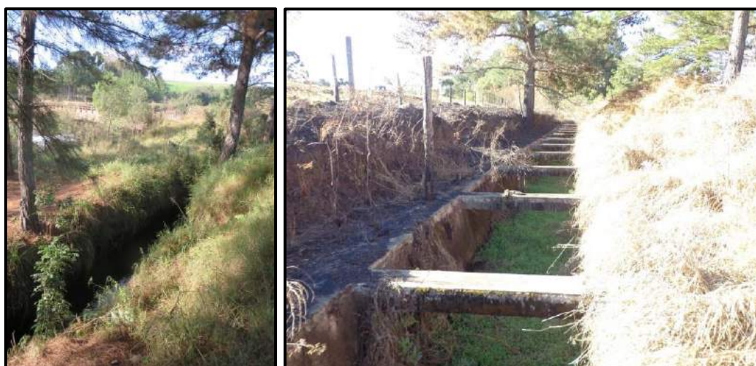
Figura 2 - Canal de adução da antiga CGH, localizado na margem esquerda do Rio do Salto.
