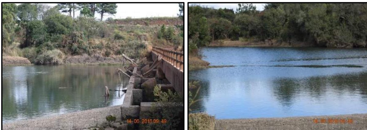
Figura 1 – Barramento e reservatório existentes na área de implantação do empreendimento.
