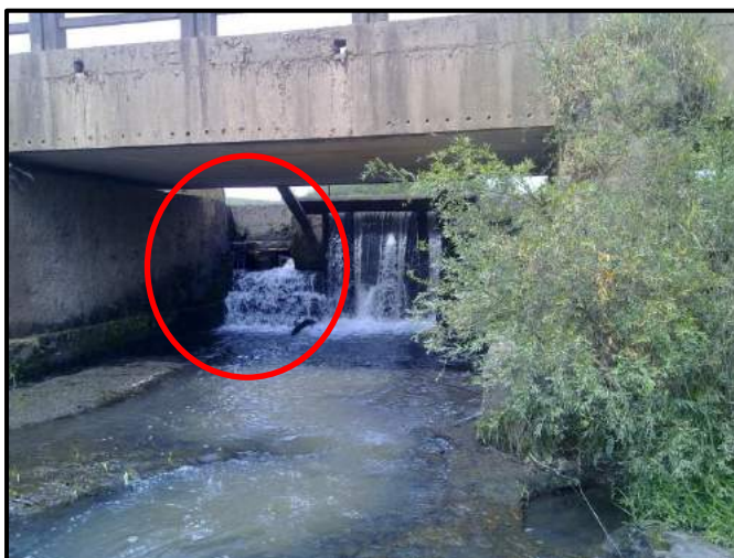
Figura 5 – Adufa existente na barragem da CGH Rio do Salto.
