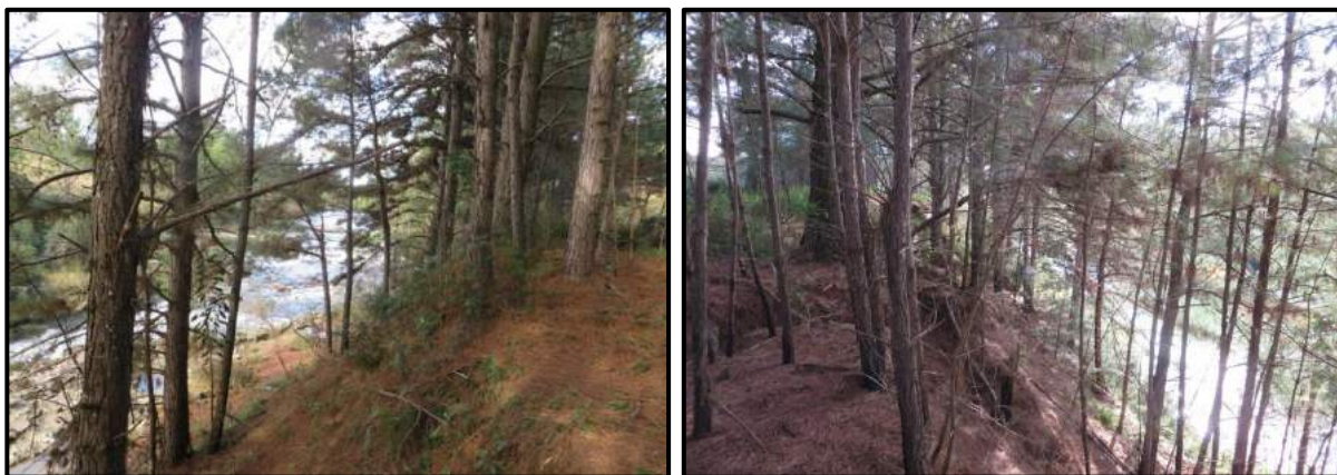
Figura 50 – Taludes com alta declividade identificados na ADA do empreendimento
