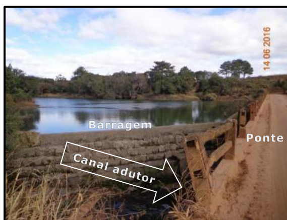
Figura 130 – Local em que será conectada o canal adutor à barragem e passará sob a ponte sobre o Rio do Salto.
