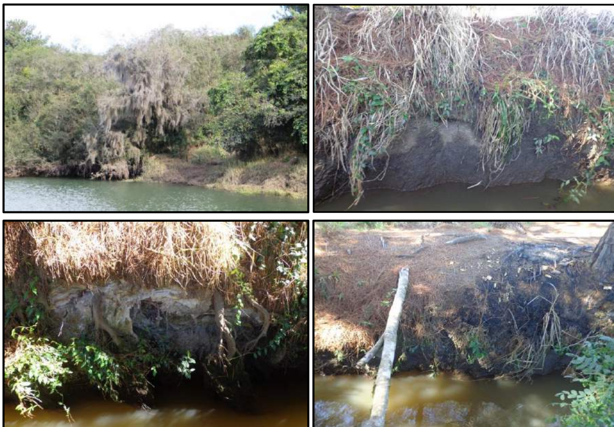
Figura 51- Porções com evidências de processos erosivos na margem do Rio do Salto.
